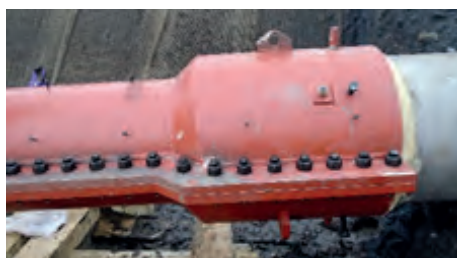
(d) End seal connection to existing pipeline nitrogen sleeve
